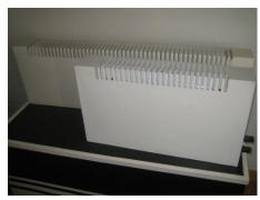
Конвекторы «Ташкент» отличаются высокой эффективностью, более длительным сроком эксплуатации, меньшим весом по сравнению с чугунными и стальными радиаторами.
